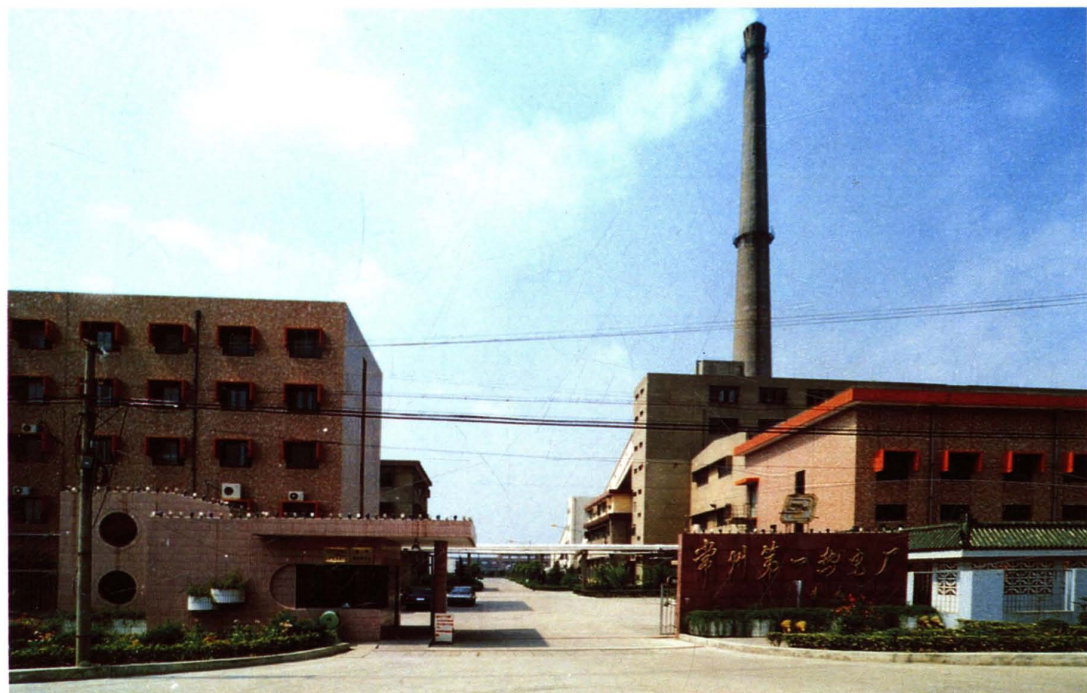
常州第一热电厂厂门
