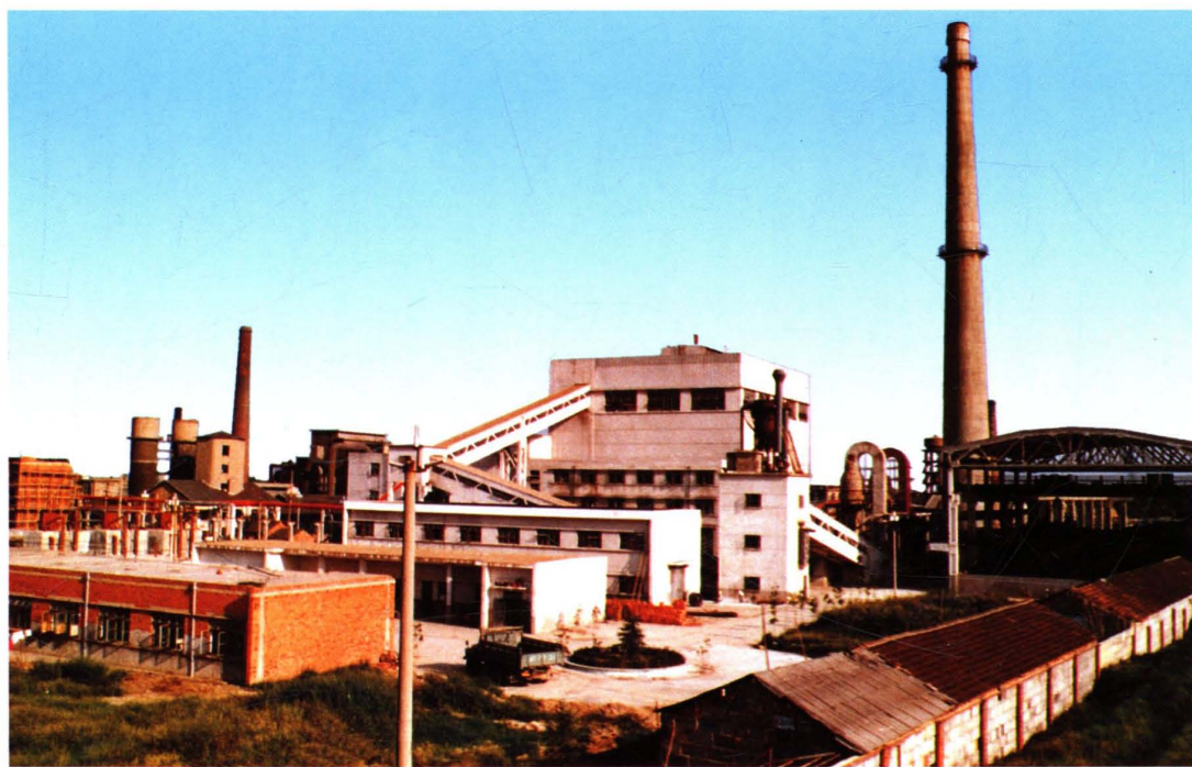
常州化工厂热电站全景
