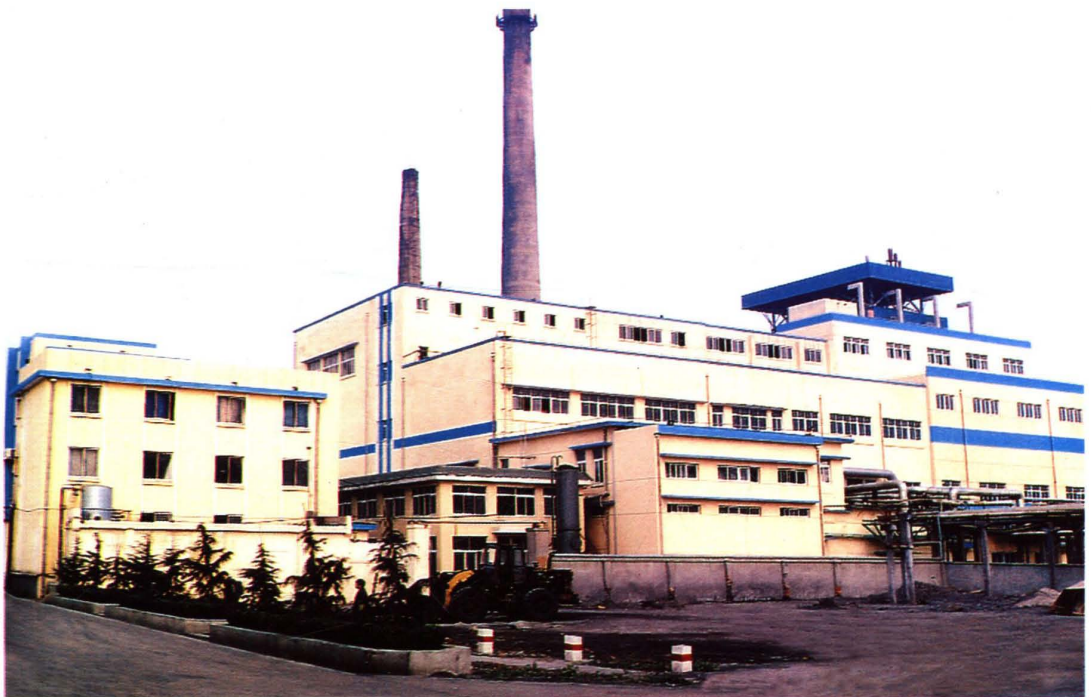
常州新亚化工集团公司热电厂厂貌
