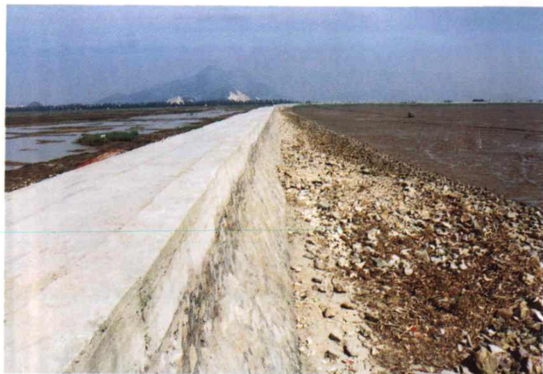
丁山一期围垦主堤坝
