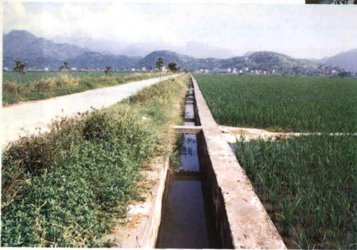
机械化疏竣河道
