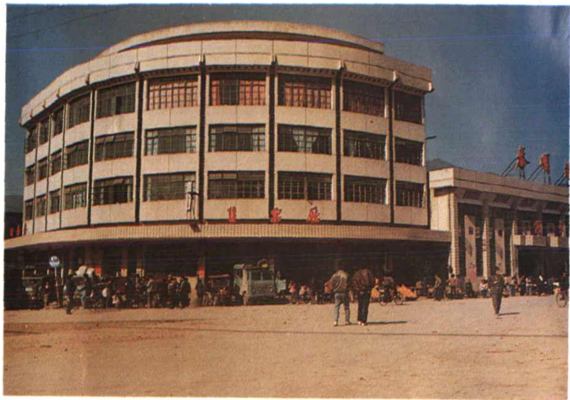
泰顺县汽车站
