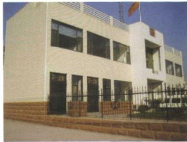
界河法庭办公大楼
