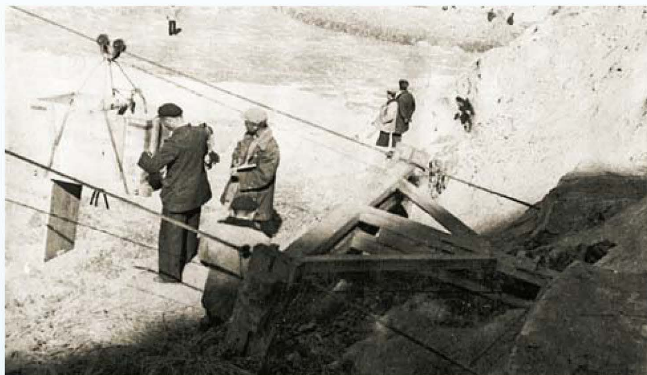
兴修水库工地
