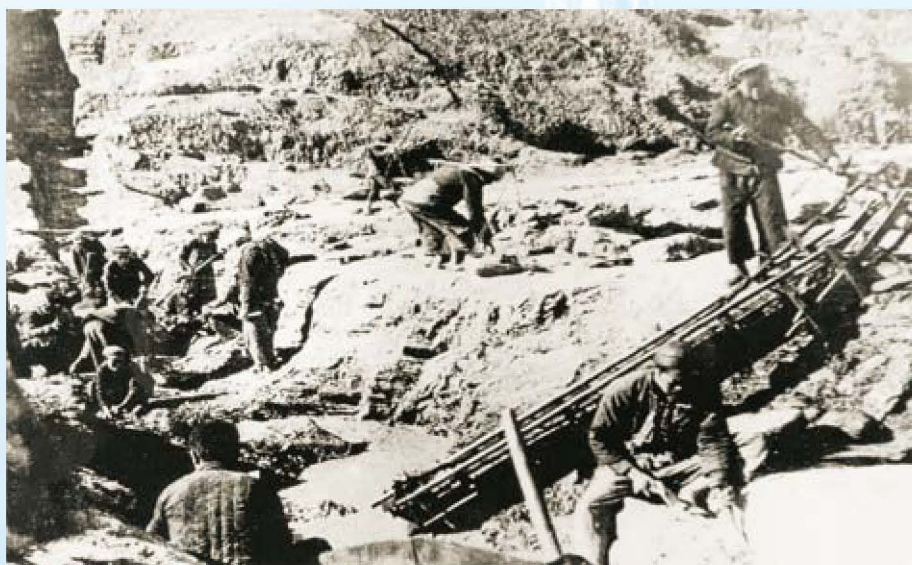
兴修水库工地
