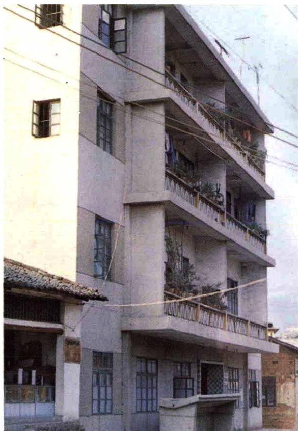
大坑口邮电支局现貌
