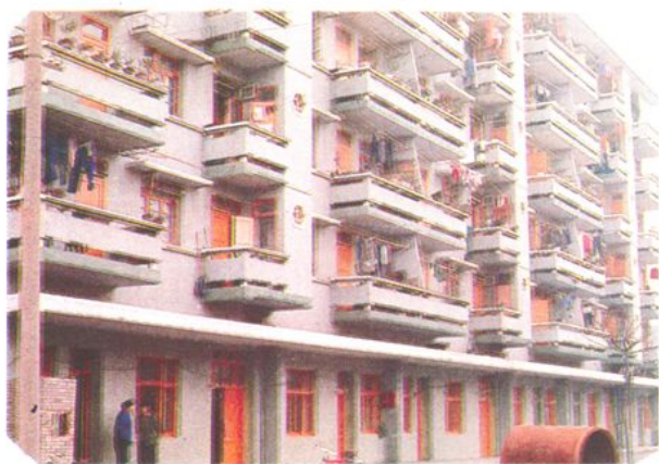
江津县轻机厂办公楼
