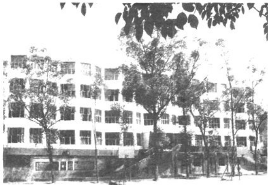
红旗中学教学大楼
