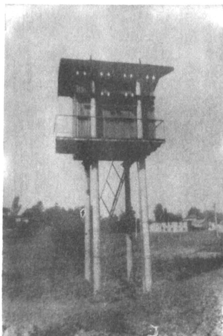
建个线路始杆（建水城南）P0001 舒予明 摄
