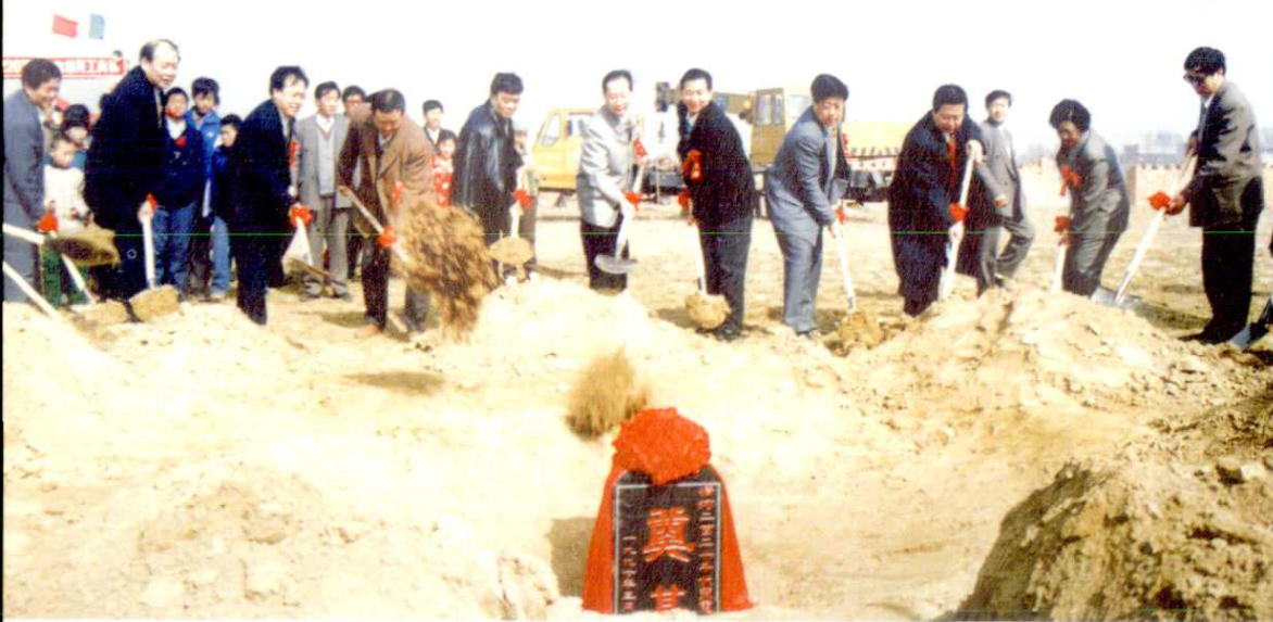
清河220千伏变电站奠基。
