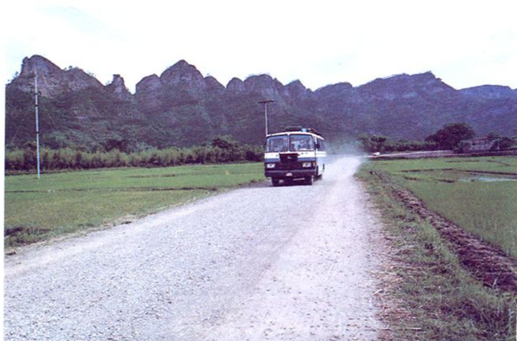
风景区穿岩十九峰下楼基段公路
