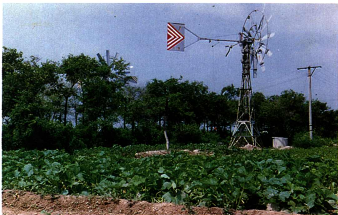
与暗管排咸设施配套的风力提水机
