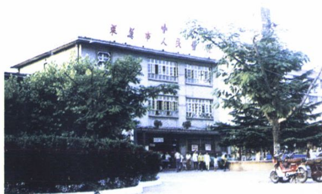
1975 年启用的县人民医院门诊楼
