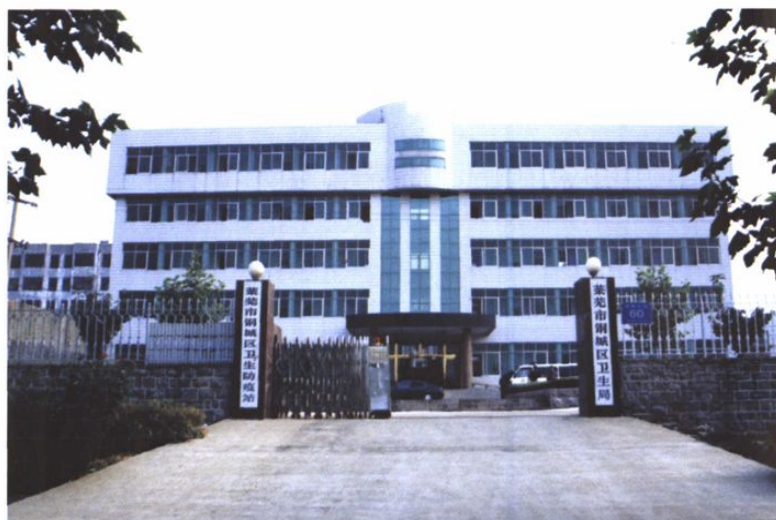
莱芜市钢城区卫生局办公楼
