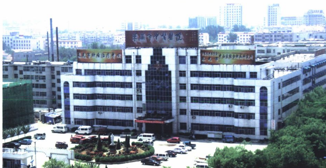
1997 年 1 月启用的莱芜市中医医院门诊楼
