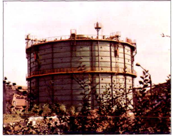
煤气回收工程煤气柜外景
