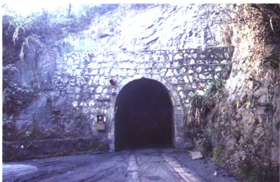
全省最长的隧道——电厂隧道
