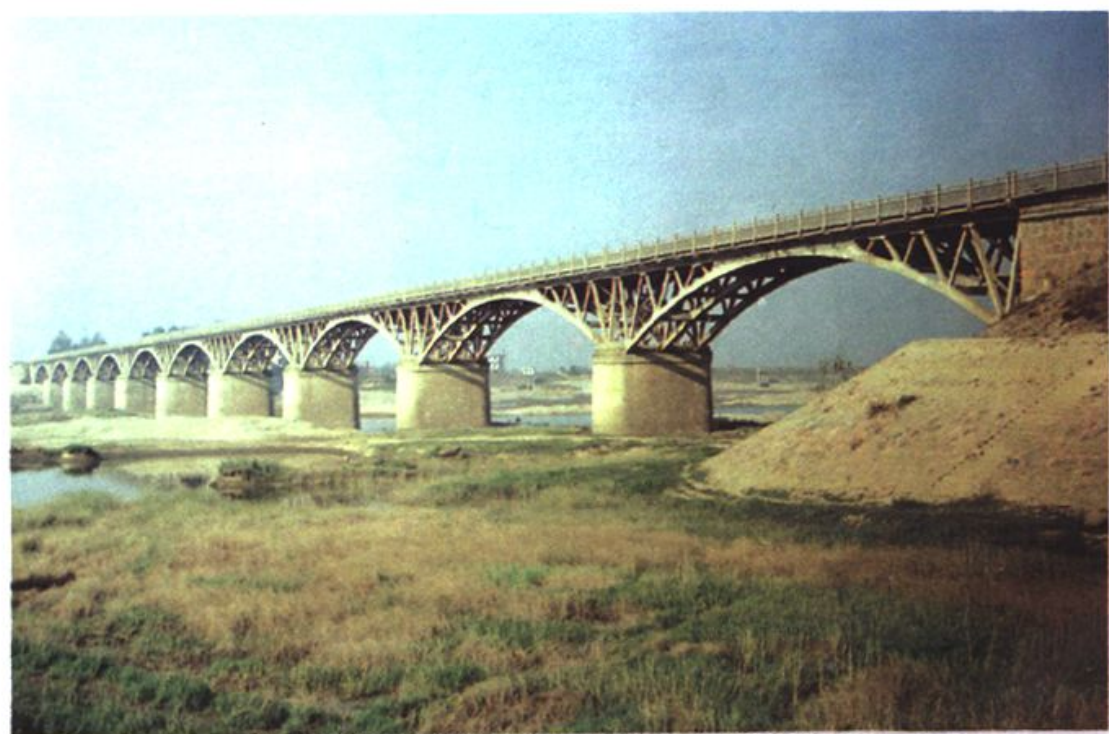
辖区最长的桥梁——贵池市杜坞桥
