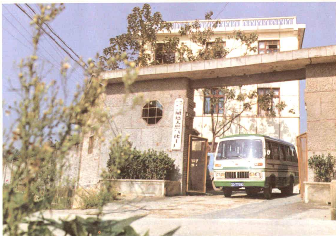
四川石油管理局威远天然气化工厂
