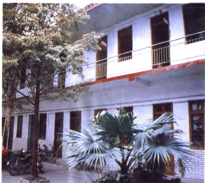
△ 射洪县商业局办公楼
