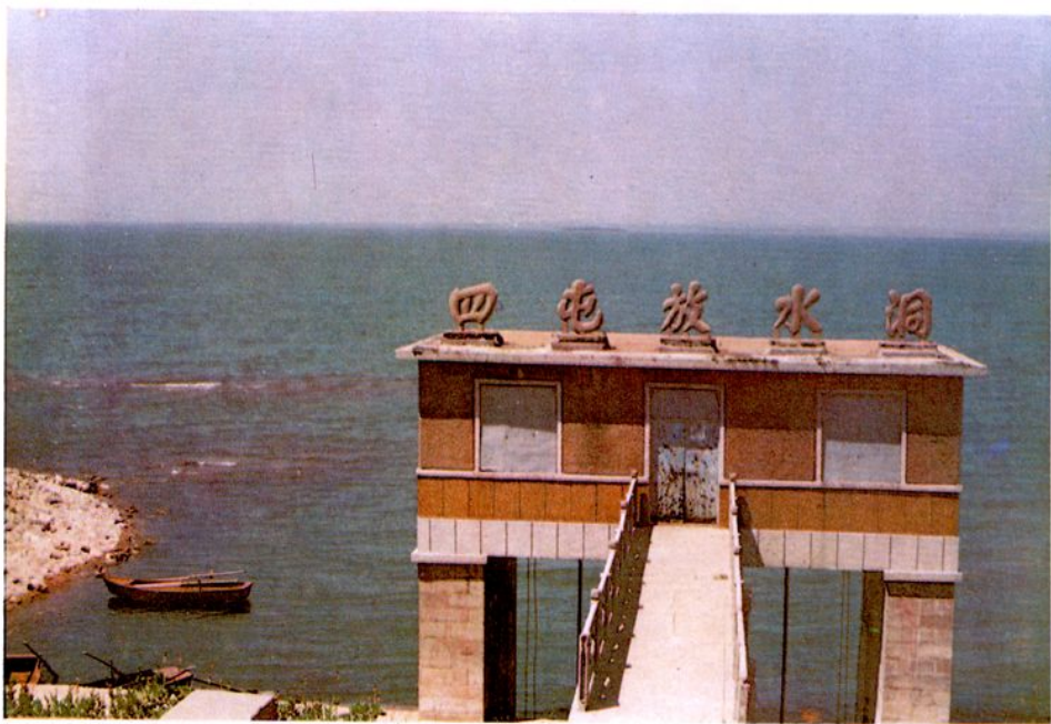
峡山水库四电放水洞
