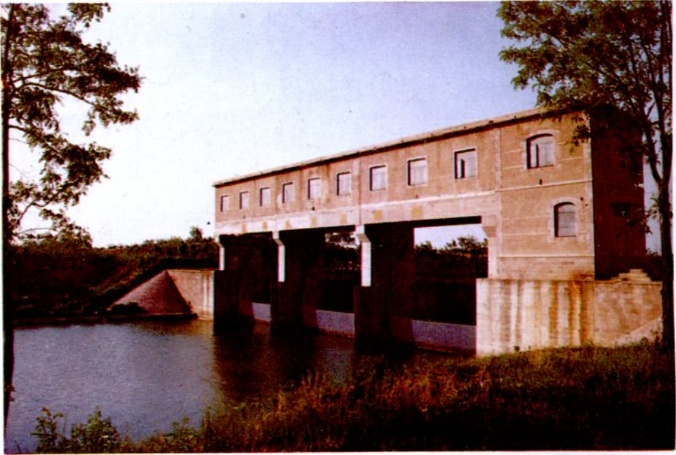
王吴水库溢洪闸
