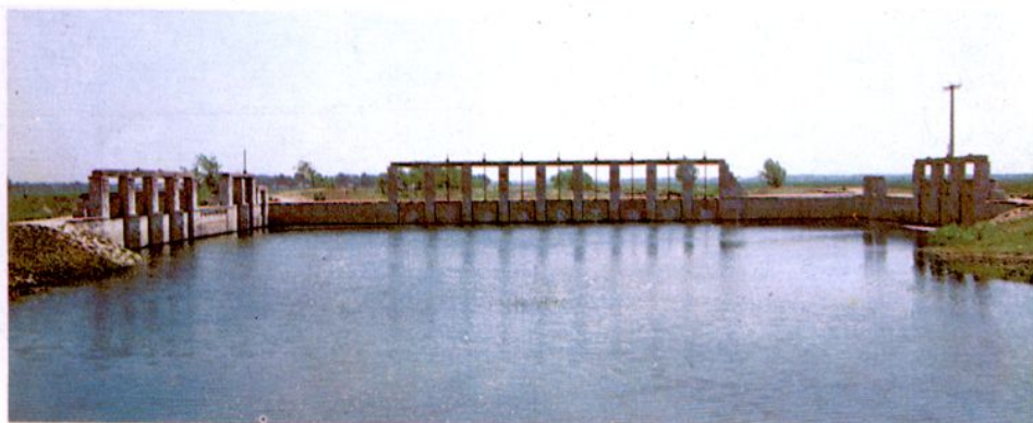
四屯灌区配水枢纽
