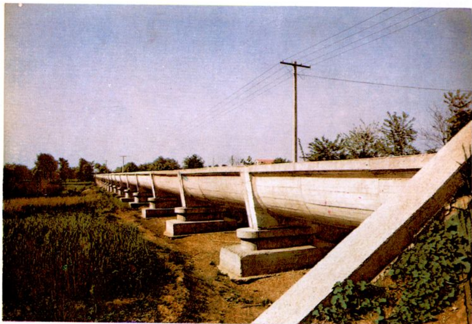
王吴水库干渠渡槽
