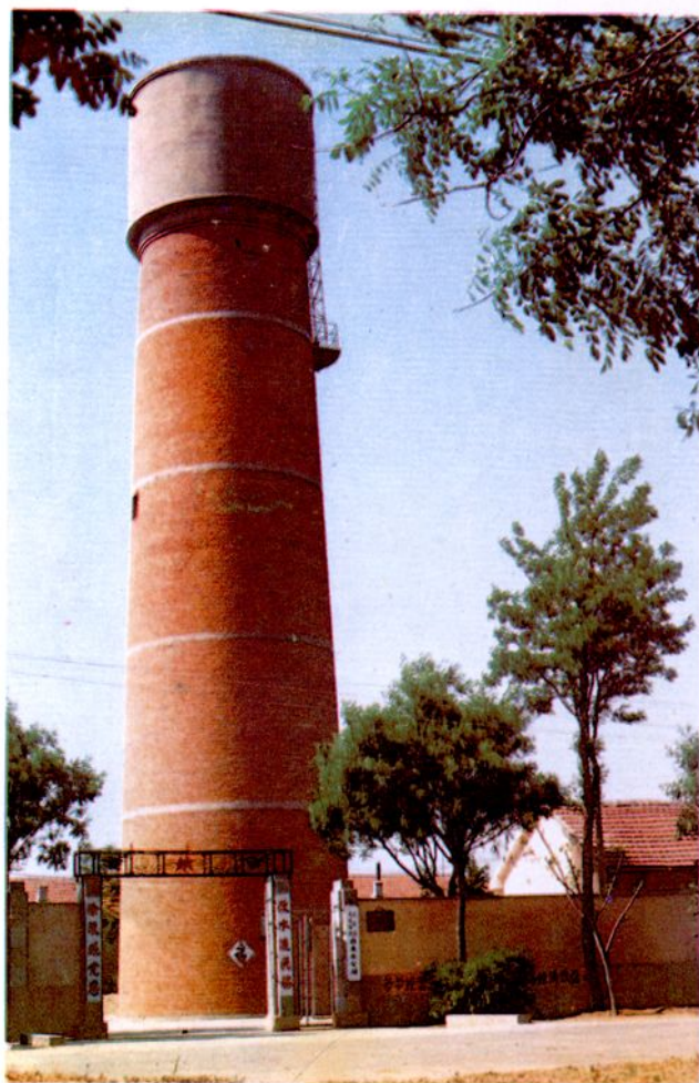
大牟家改水防氟供水站
