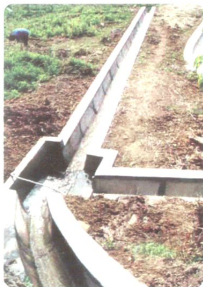
西张村镇南沟村“U”型渠道节水灌溉项目一角
