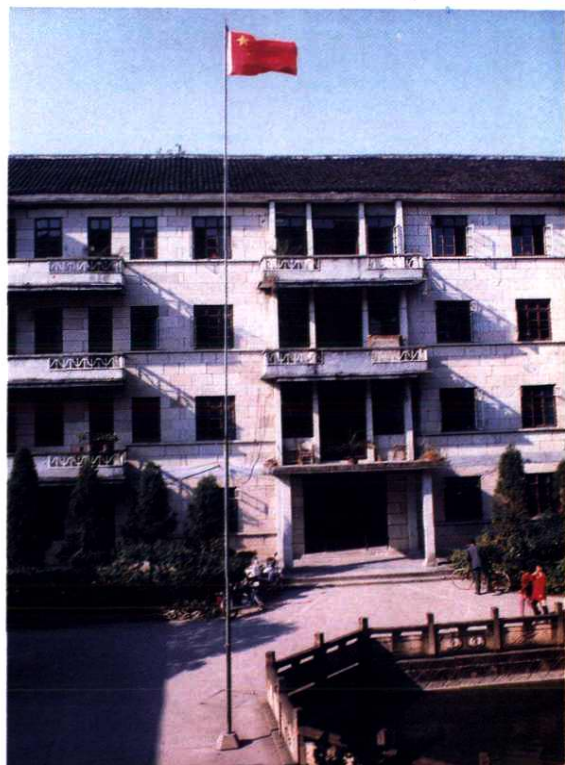
缙云县人民政府办公大楼
