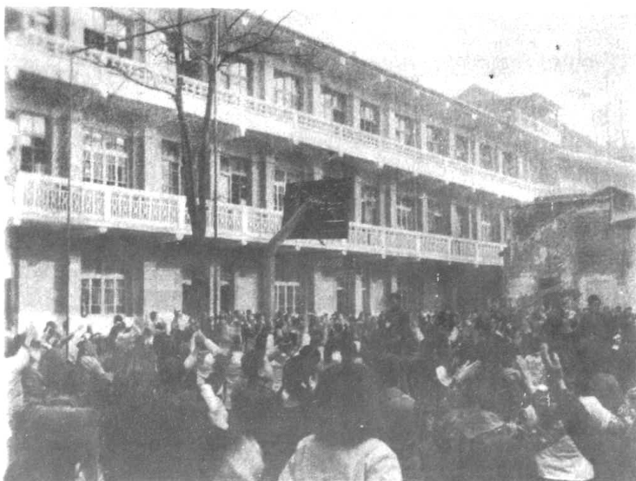
东乡镇红专路小学1982年特大洪水袭击后，在党和政府的关怀下，建起了教学大楼和礼堂。
