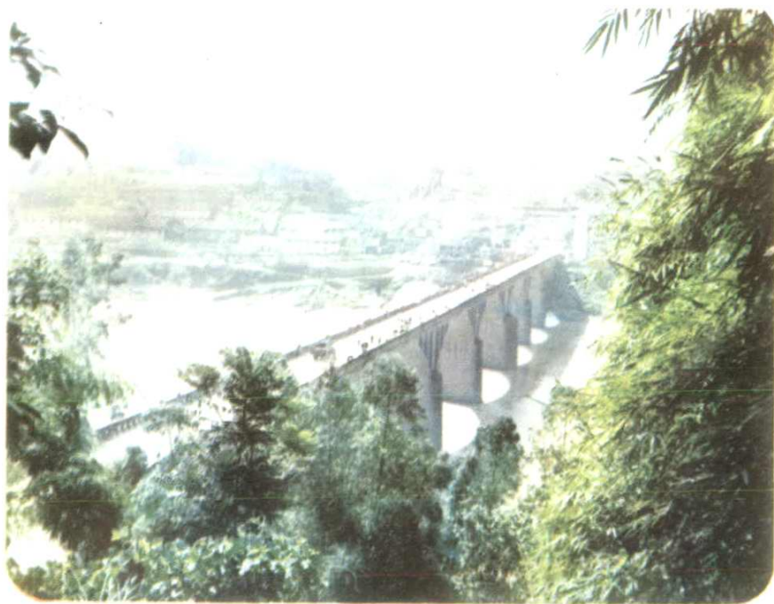
“江口大桥”位于县城东3里许的江口，横跨州河，北连宣（汉）双（河）公路，南接宣（汉）万（县）、宣（汉）南（坝）公路，是我县最大的一座悬腹线公路大桥。桥长390.5米，高22.9米，宽9米。
