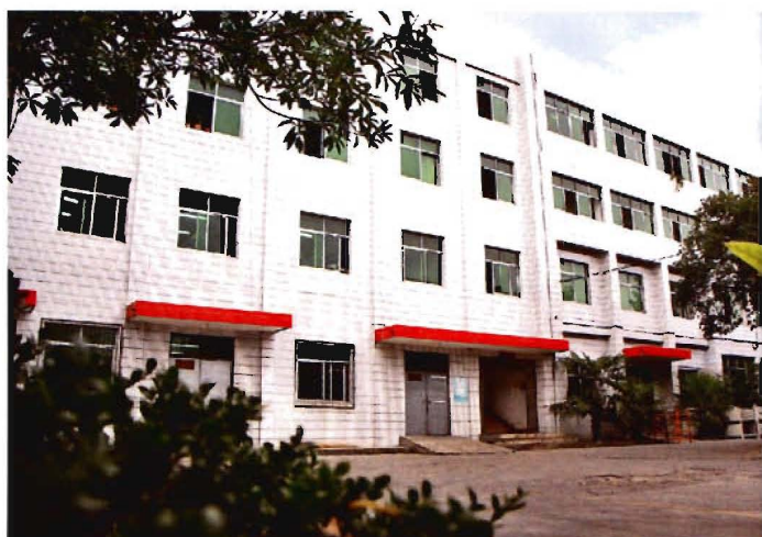
泵业公司新建的技术质量大楼
