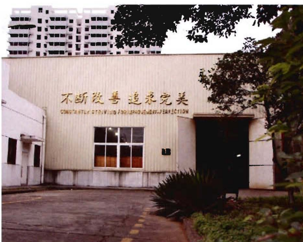
泵业公司新建的零件分厂厂房
