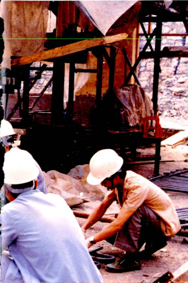
工人正在紧张安装新设备
