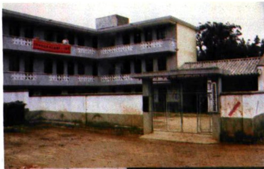
新建的双龙村公所办公楼
