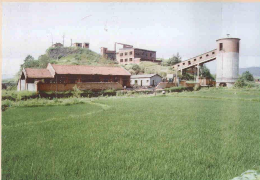
广山集中破碎工段外景
