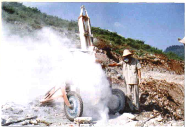
岩峰车间半自动潜孔钻作业
