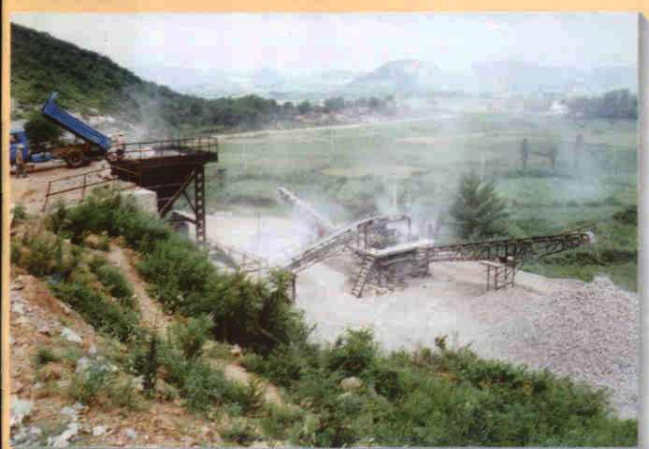
普通石灰石破碎系统
