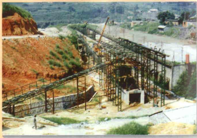
建设中的优质石灰石破碎系统
