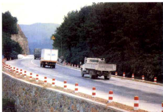
104 国道杭父线余杭段公路
