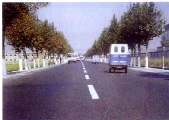
104 国道杭温线萧山段公路
