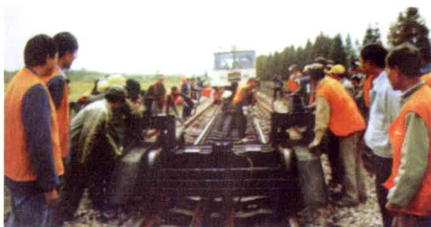
铺设无缝线路更换钢轨
