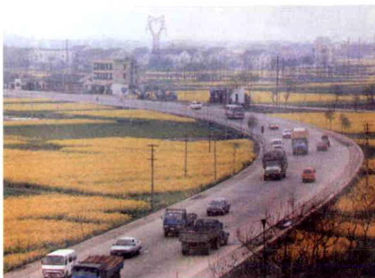
省优良工程——320 国道杭枫线 (杭州段)
