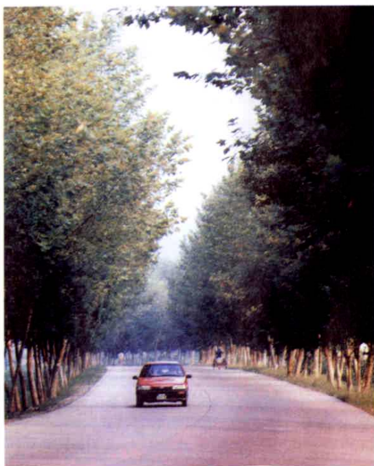
320 国道杭新线建德段公路
