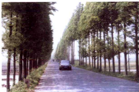
余杭县良渚至塘栖公路
