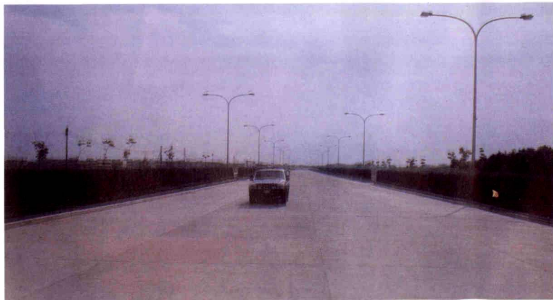
杭州至下沙经济开发区公路
