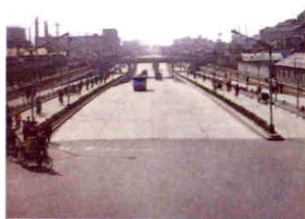
艮山门立交引道
