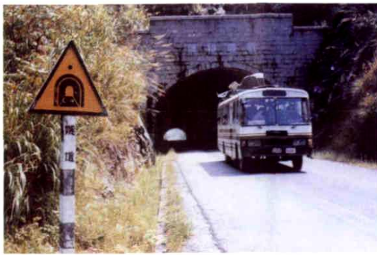
新淳线九龙隧道
