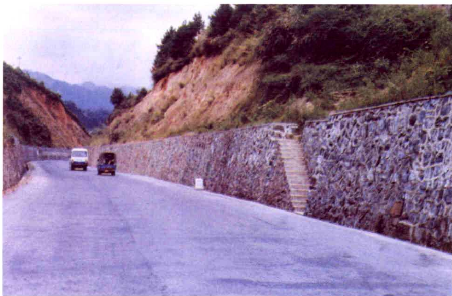
经降坡拓宽改建后的接官岭公路
