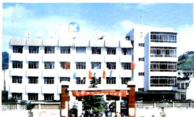
中共白泉镇委、镇人民政府办公楼
