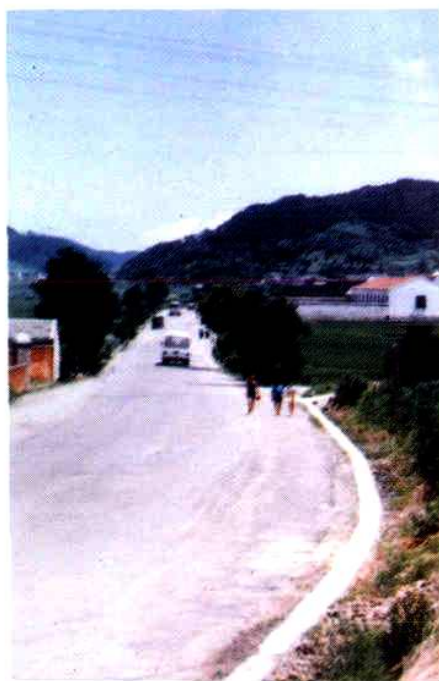
定西公路白泉段新貌
