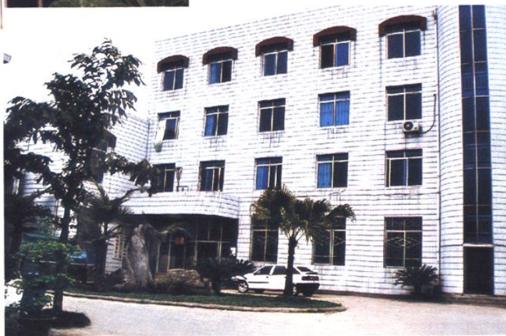
赵场街道机关办公大楼
