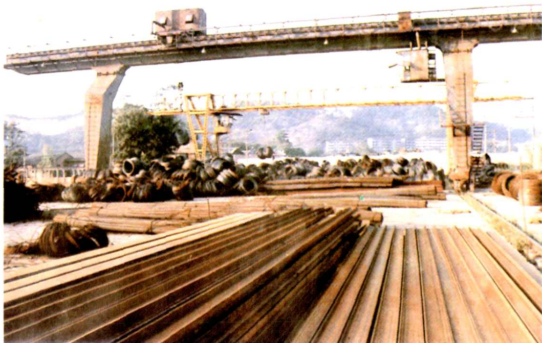
● 福州市金属公司堆场龙门吊
