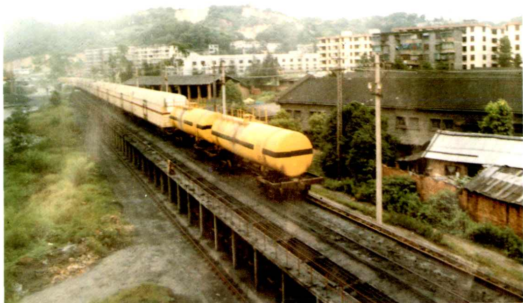
● 福州东煤场运煤专用线
