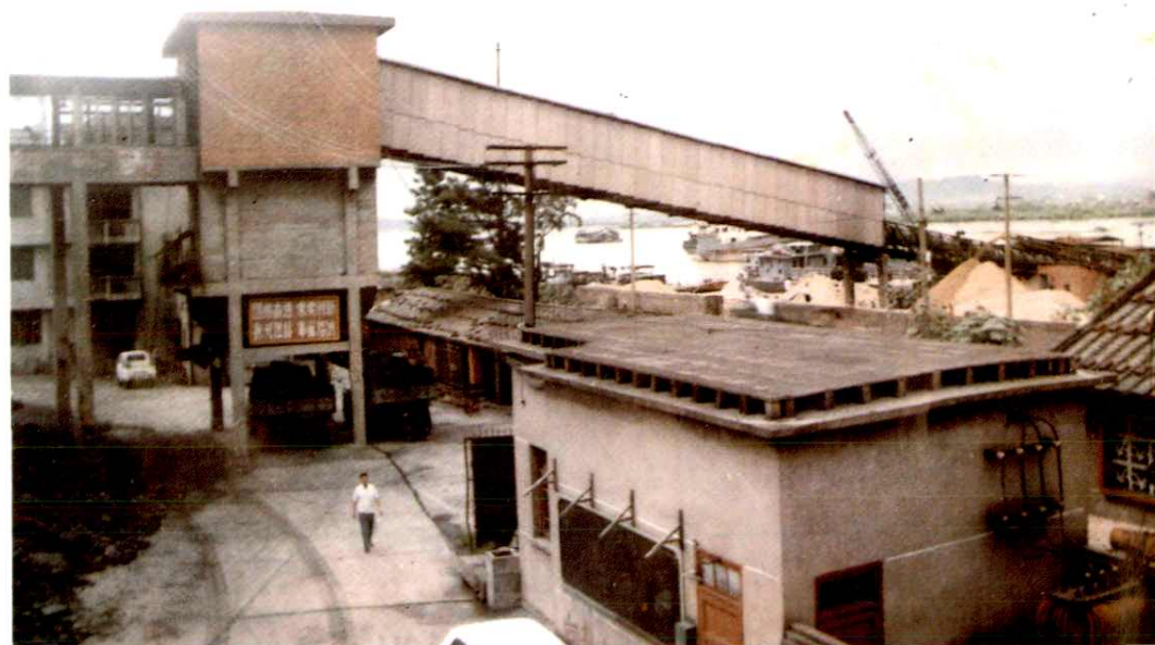
● 福州鳌峰洲煤码头自动装卸线
