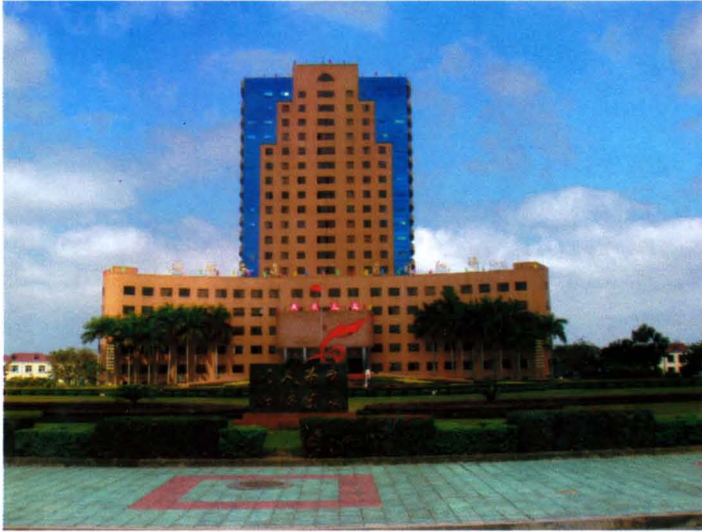
儋州市新市委大楼
