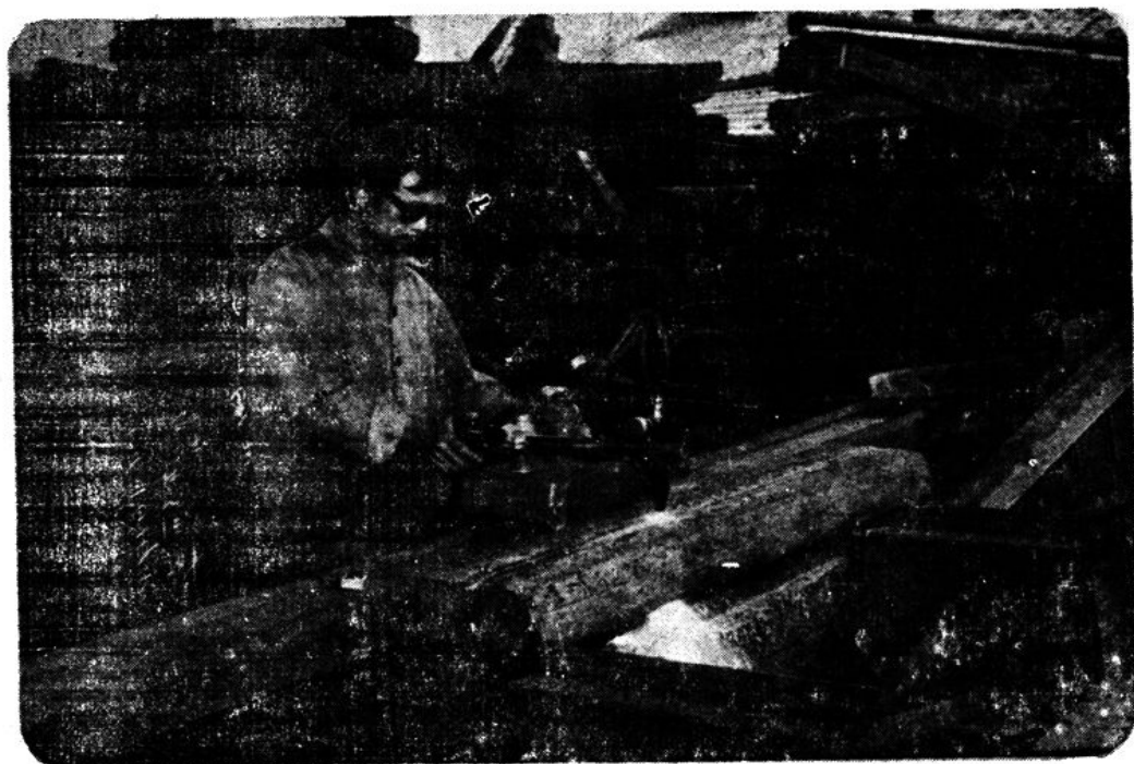
型钢厂工人正在氧割钢锭
