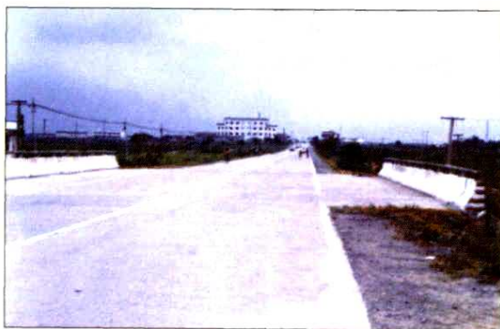
投资 400 万元兴建的沿江公路至镇区的接线工程
