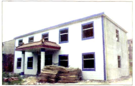
建设中的辛丰镇文化中心
