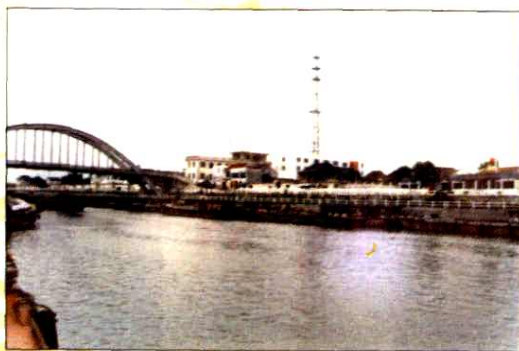
整修后的京杭大运河辛丰段
