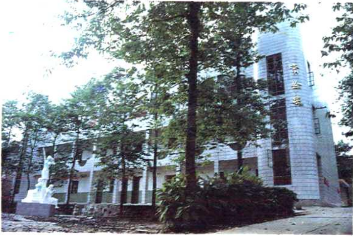
桥西中学实验大楼
