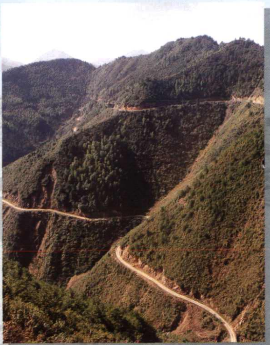
新白公路傍山路段全貌
