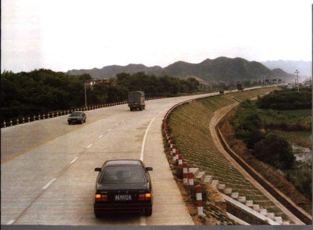
205与320连接线高填土护坡及绿化带
