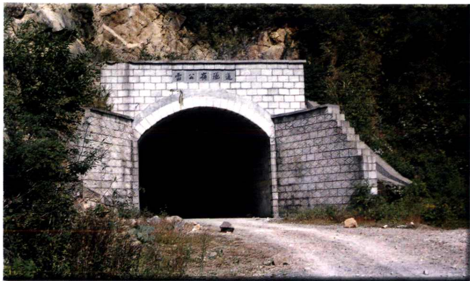
新（桥）白（马）公路雷公嶺隧道， 全长 350 米
