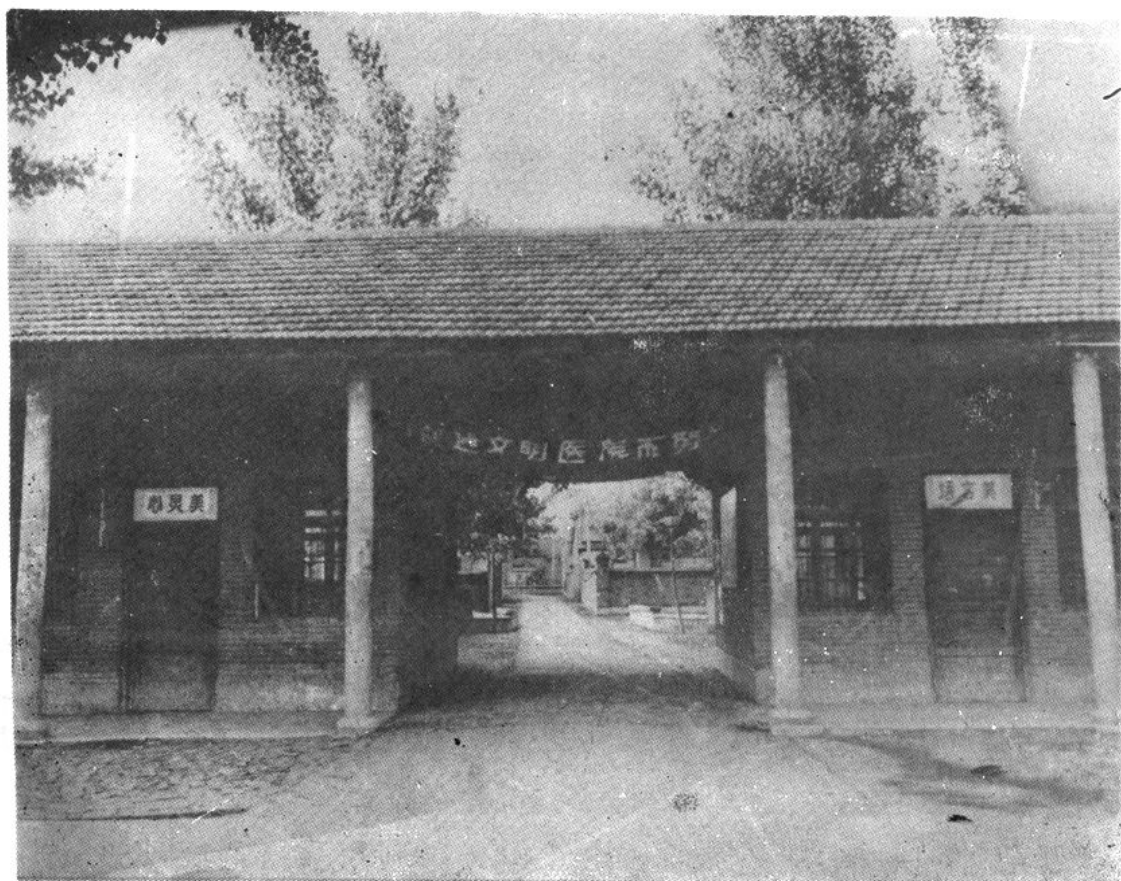
固墙乡卫生院
