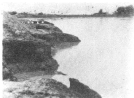
洪河左岸贺道桥堤防顶冲 处冲毁长 120 米
