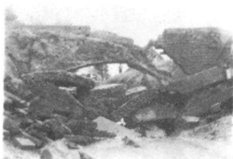
邵店籽粒大队生产桥被冲 毁
