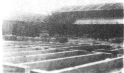
上蔡县水利渔业局预制 厂构件预制一角
