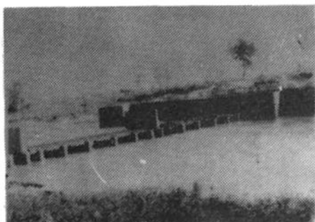
洪河西洪拦河双铰式自动翻转闸
