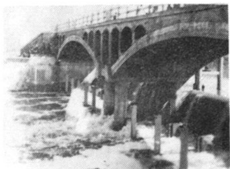
杨岗河西洪钢筋混凝土双曲拱桥
