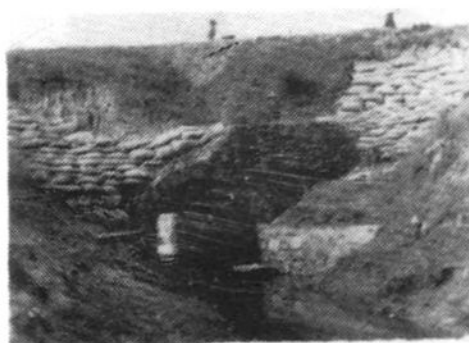
黄埠南柳堰河右岸高湾闸被冲毁
