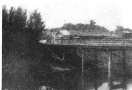
洪河贺道桥钢筋混凝土井柱“T”型梁板桥
