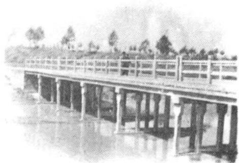
北汝河马埠口钢筋混凝土打桩“π”型板桥
