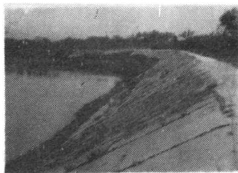
南汝河左岸新庄桩基混凝土 护坡
