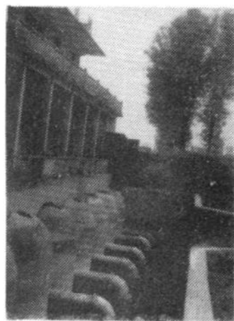
引水上岗马埠口第一级机灌站前池与机埠
