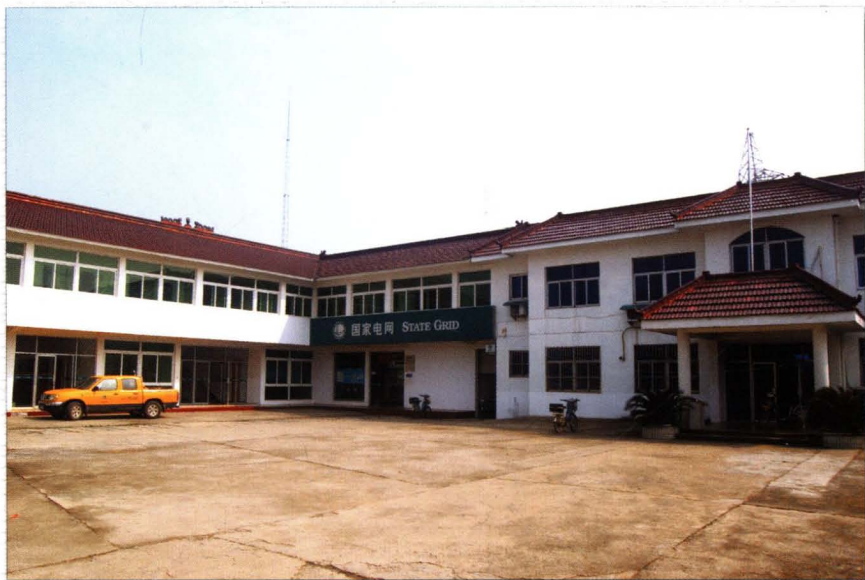
江心洲电力管理站 (2010年10月15日摄)
