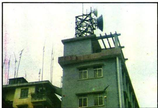
增城县电信大楼微波塔
