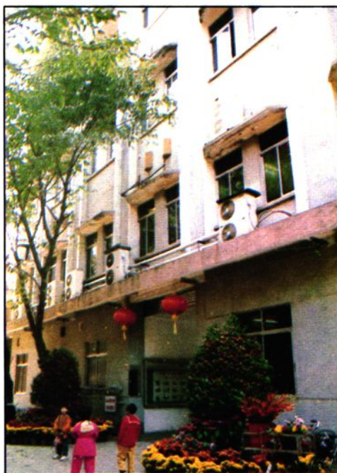
增城县邮电局通信楼
