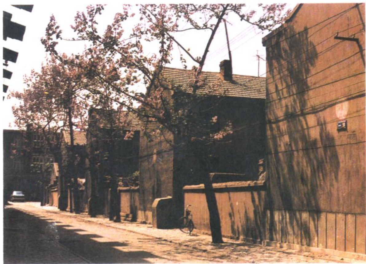
潍坊市供销社院内东宿舍楼
