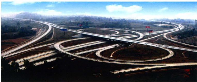
南宁环城高速公路
