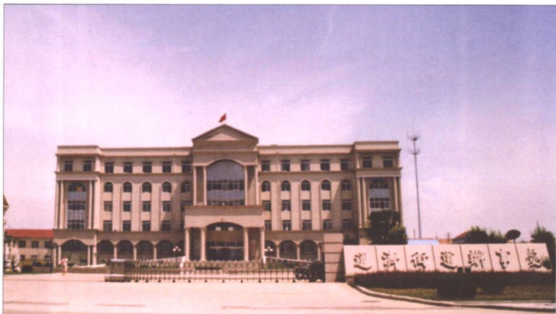
通济街道办事处办公大楼
