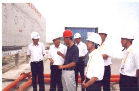
为国家南水北调工程提供优质供电服务
