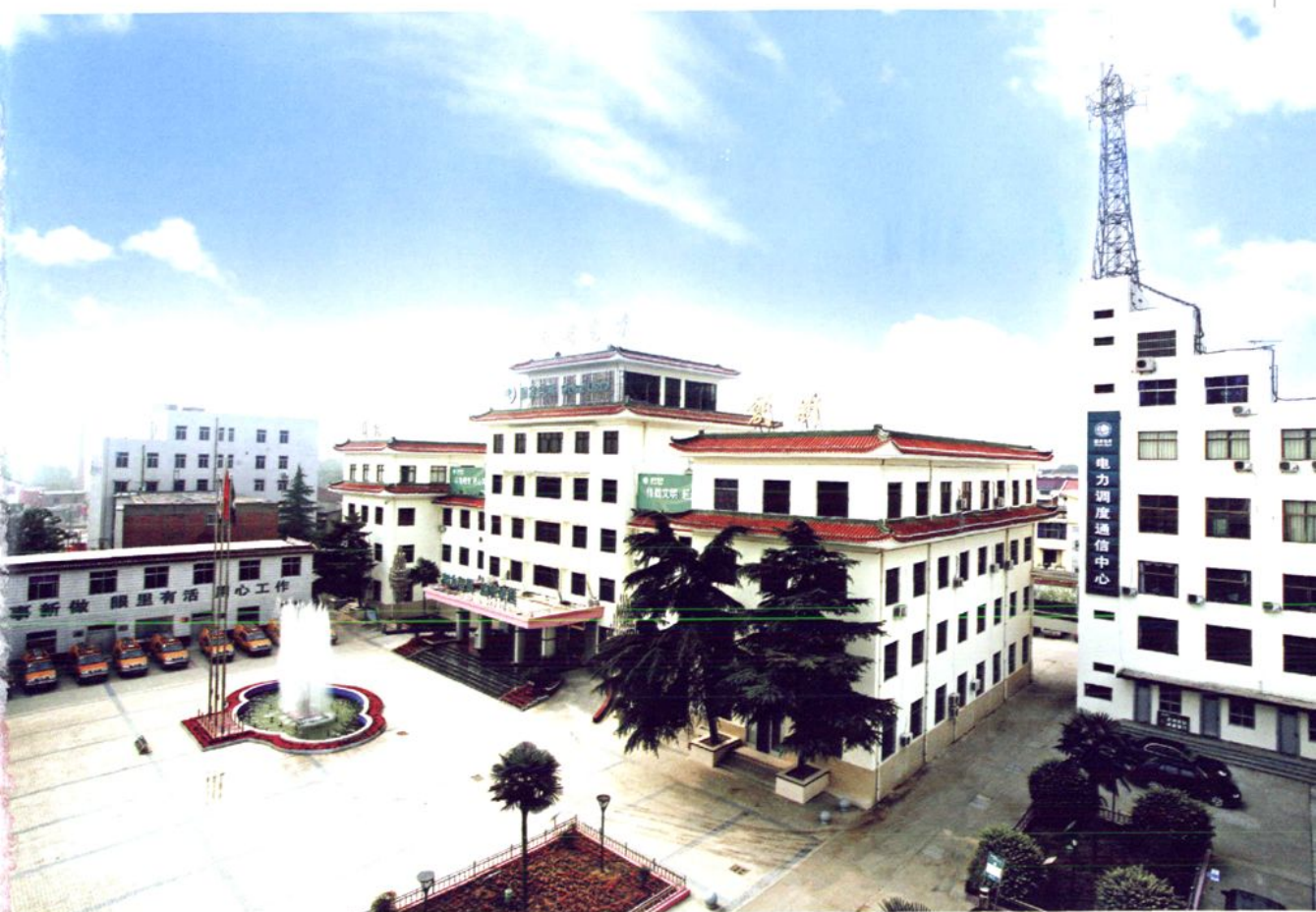
温县供电有限责任公司机关办公楼
