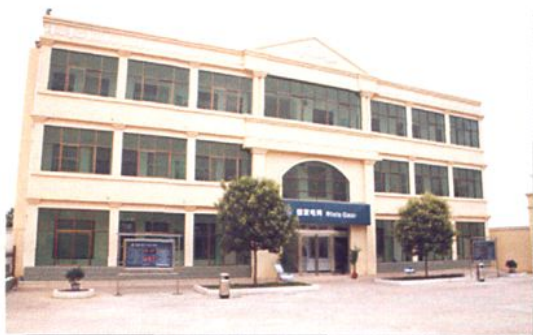
陈家沟供电所
