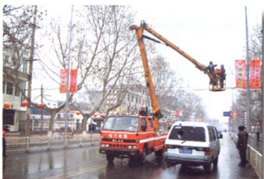
安装维护路灯
