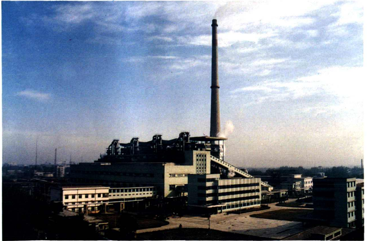
石家庄热电厂东厂
