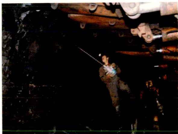
大雁矿务局二矿井下工人钻眼
