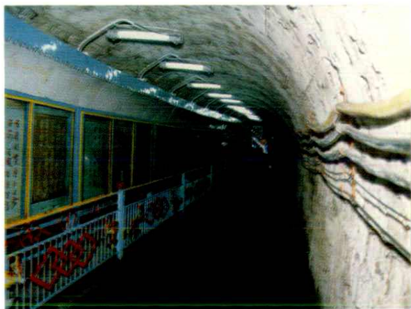
大雁矿务局一矿标准文明矿精神文明巷道
