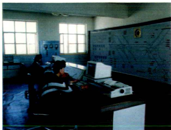
乌达矿务局黄白茨煤矿调度室
