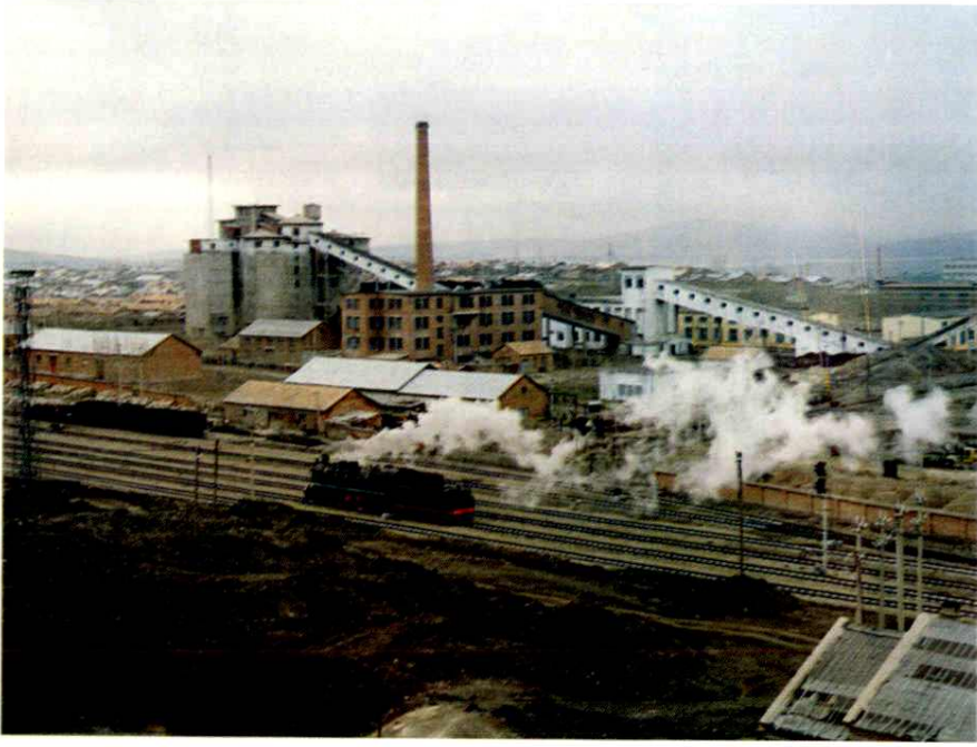
大雁矿务局二矿全景
