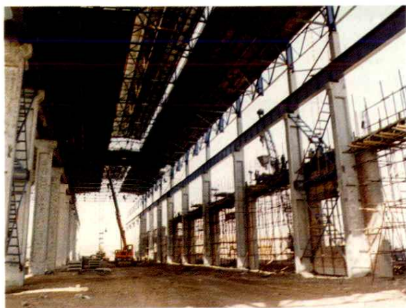
准格尔煤田在建设中
