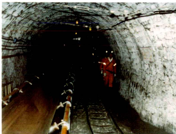
大雁矿务局矿山救护队 在井下巡视
