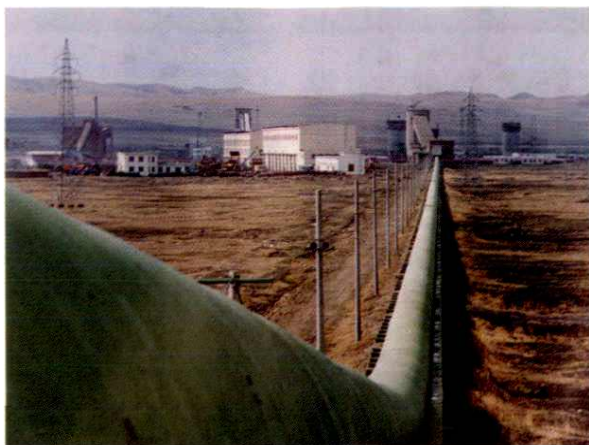
霍林河矿区的全国最长封闭式运煤胶 带输送机
