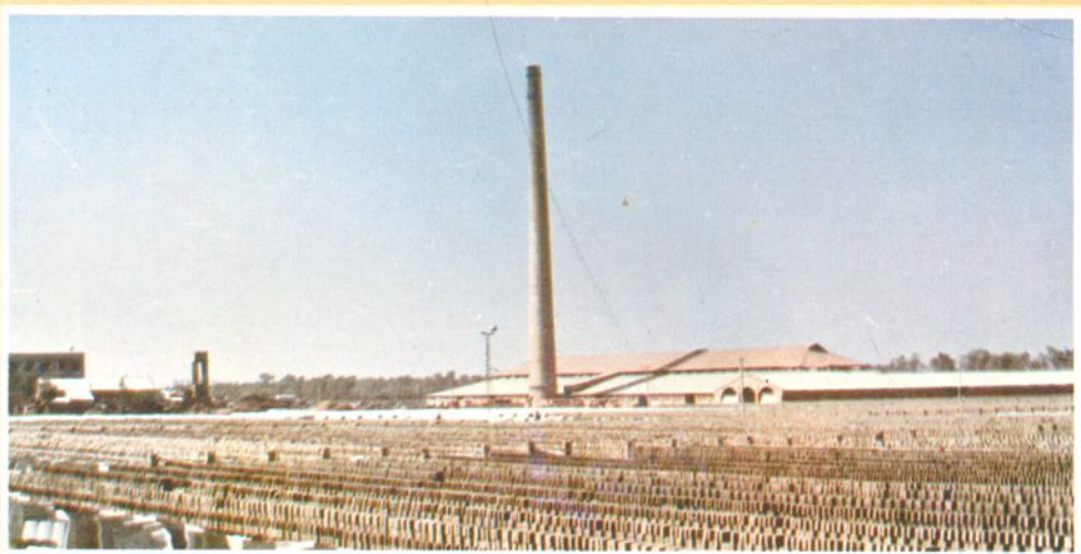
岑河镇第二砖瓦厂 （雷祖华摄）
