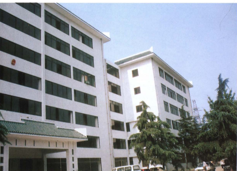
▲南阳市人民政府办公楼(七局四公司)
