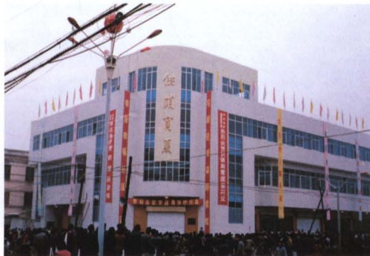
▼桐柏供销商厦 (七局工程承包部)
