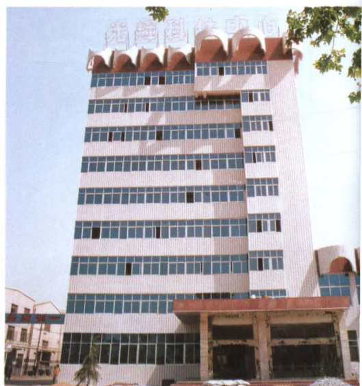
▲南阳光辉机械厂办公楼(七局四公司)
