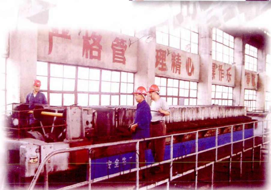
● 建造煤泥水压滤工程，确保了再生水 质量和洗煤生产用水
