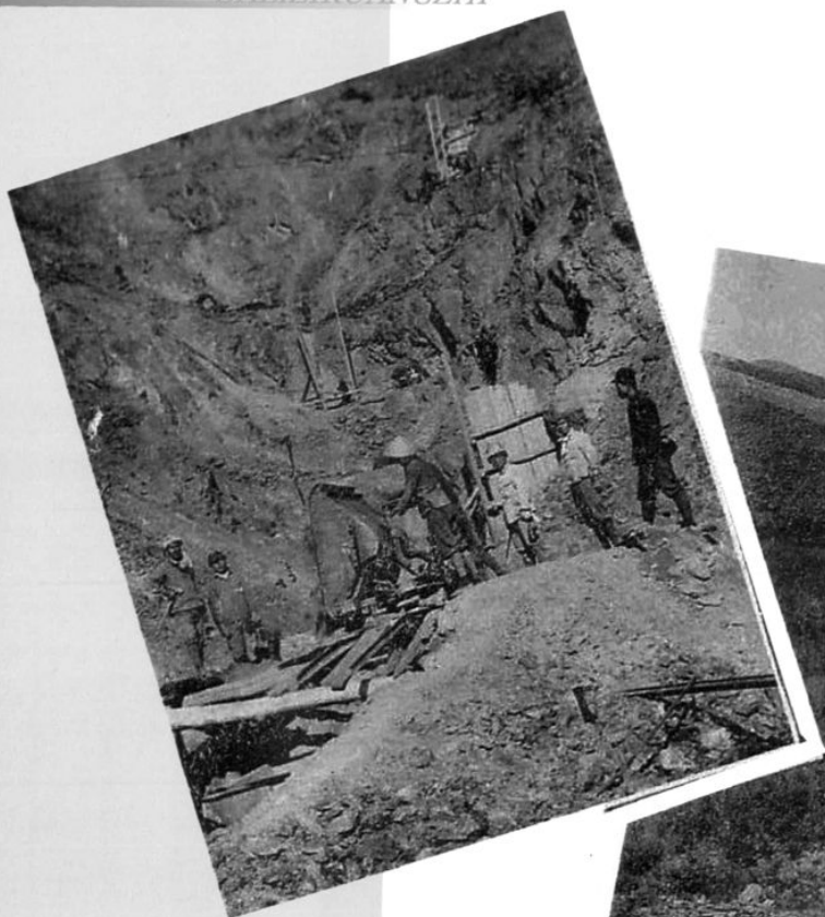
十五号坑下部矿石搬运第一现场
