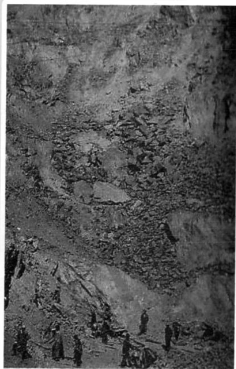
西上部10号坑探矿状况
