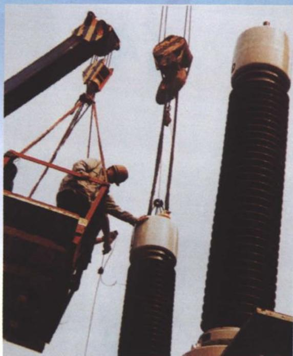
1999年，重庆市第一座采用220千伏GIS组合电器和全密封式变压器的变电站——220千伏大溪沟变电站正在进行主变压器安装
