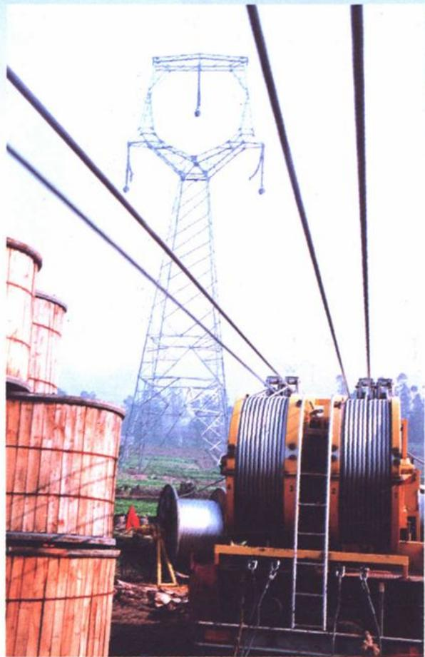
1997年12月, 500千伏长寿一万州输电线全线贯通, 图为线路施工放线
