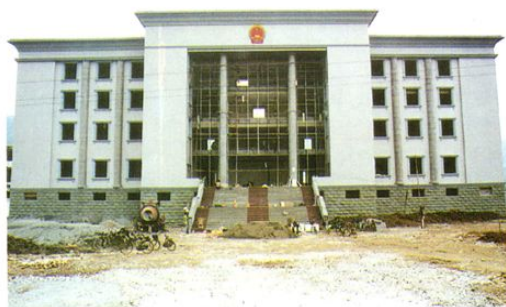
▲ 建设中的芦山县人民法院审判大楼
