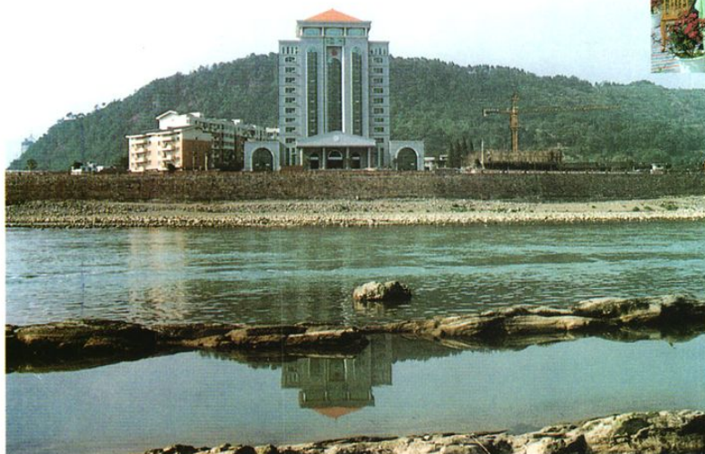
▲ 座落在青衣江畔的中级法院审判大楼（2001年开工，拍摄时尚在施工中）
